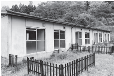
空き家になっている町営住宅
