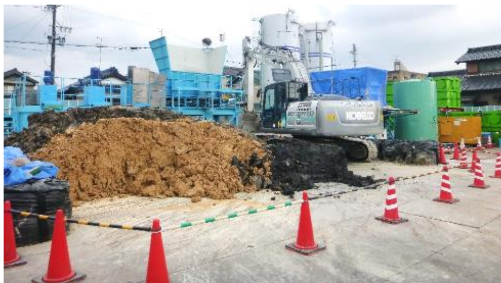
防災対策事業 実施工事（充填剤を作る設備（プラント））
