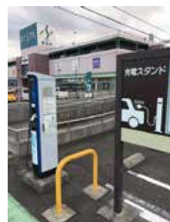
▲北側駐車場に設置されている電気自動車充電スタンド
