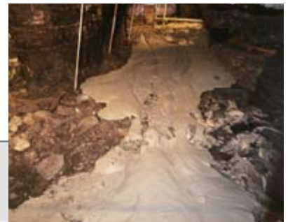
▲ 流動化処理土が亜炭鉬廃坑内に流れ込む様子
