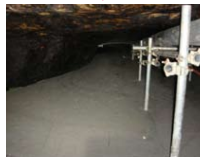
▲ 流動化処理土の打設完了の様子
