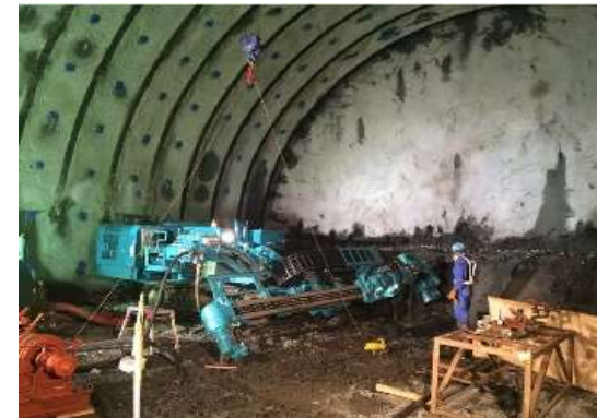
先進ボーリング
