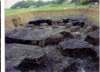
東海環状自動車道建設現場
