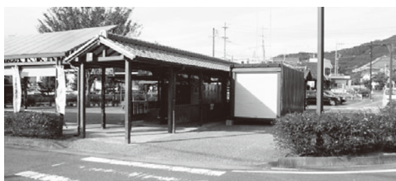
ごきごき広場に設置されたコンテナ、ロッカー
