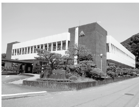
耐震性が心配される本庁舎
