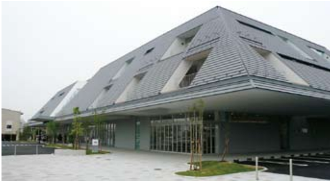
北方町新庁舎の全景
