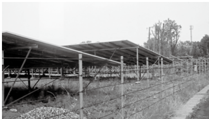
設置がひろがる太陽光発電施設
