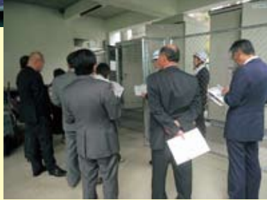
蓄電池施設など (向陽中学校 校舎下ほか)
