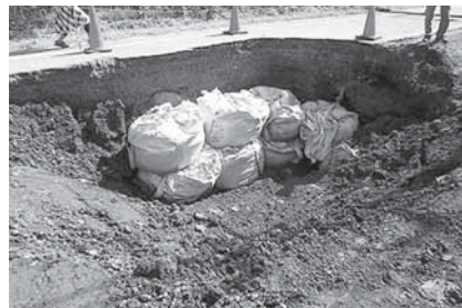
【比衣地区金ヶ崎陥没状況】
