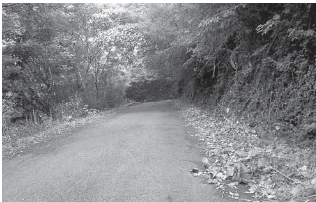
【八高林道の状況】
