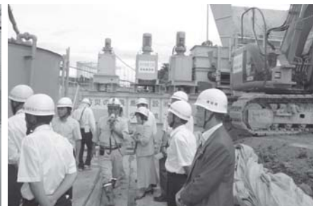
充填工事現場
