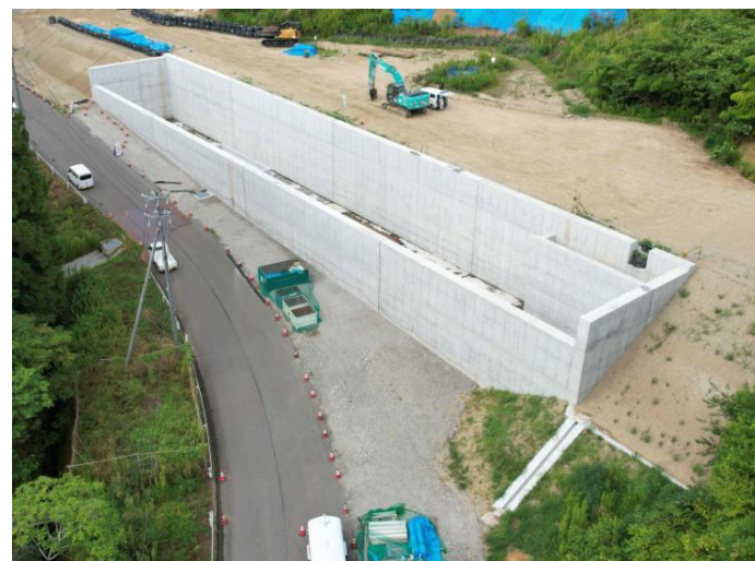
①沈砂調整池の設置(2024年12月完了)
