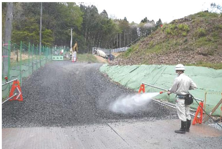
工事施工ヤード出入り口付近の散水
