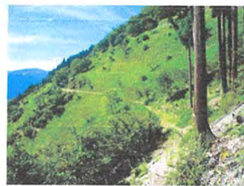
治山工事を行った森林
